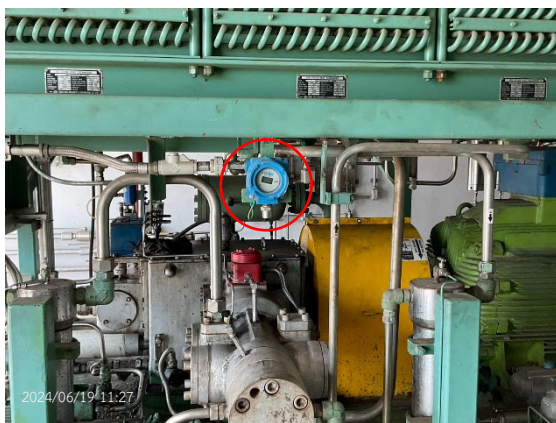
ติดตั้งเครื่องส่งสัญญาณเมื่อเกิดก๊าซรั่ว (Gas Detector)
